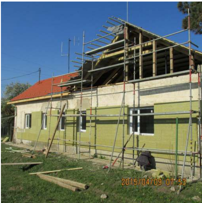
Jó ütemben halad a mentőállomás felújítása
