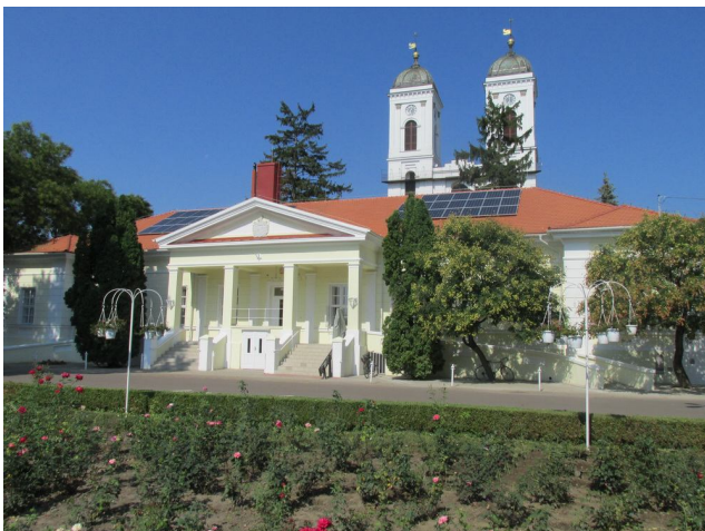
A városháza felújított homlokzata, a tetőn a napelemekkel
